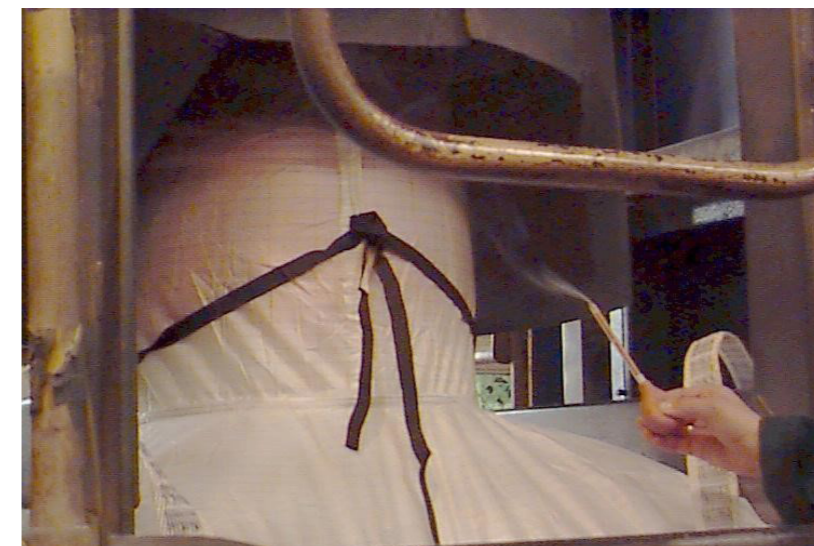
(Reproducido con permiso) Figura 9.10 - Sistema de ventilación eficaz
